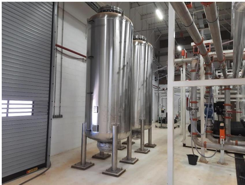
Figura 10 – Tanques Hidropneumáticos instalados para água desmineralizada.
