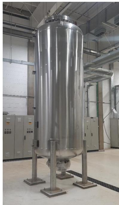
Figura 8 – Tanque Hidropneumático instalado (Diâmetro = 1,4 m e Altura = 4,6 m).
