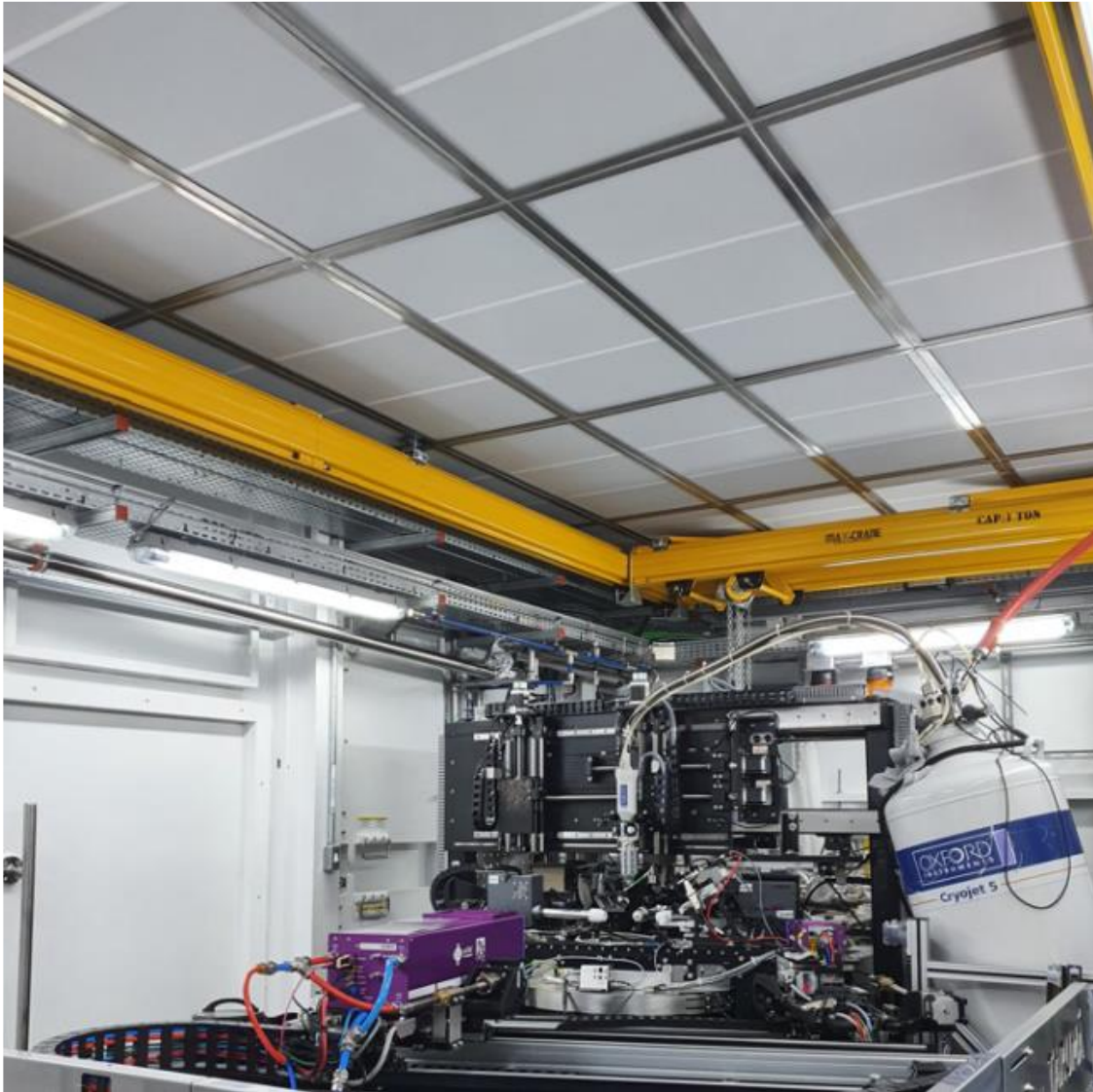
Figura 1 - Forro do tipo tela utilizado em ambientes limpos
