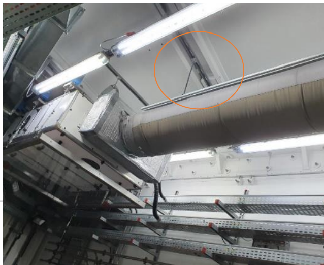
7 - Ponto de fixação da Optics Hutch – Carnaúba
