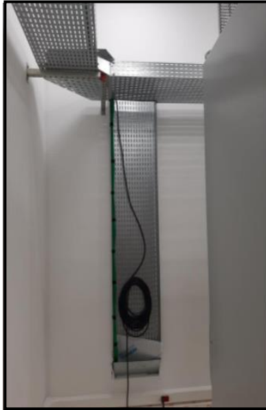
Figura 12: Acabamento de infraestrutura existente
