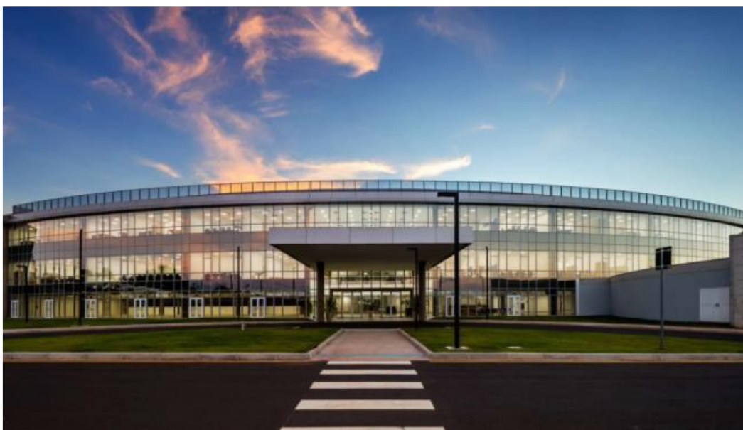
Figura 1 – Fachada do Sirius.
