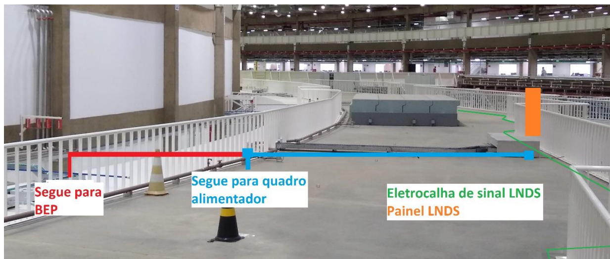
Figura 1 – Montagem geral alimentação e aterramento painéis LNDS
