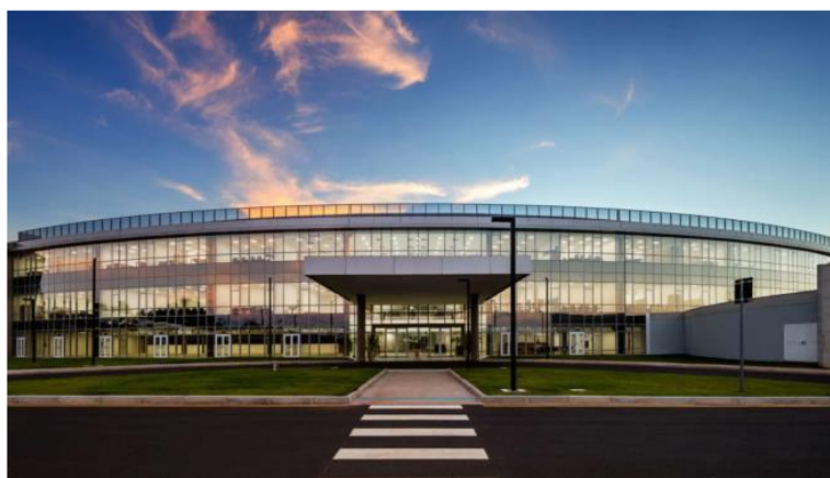
Figura 1. Fachada do Sirius.
