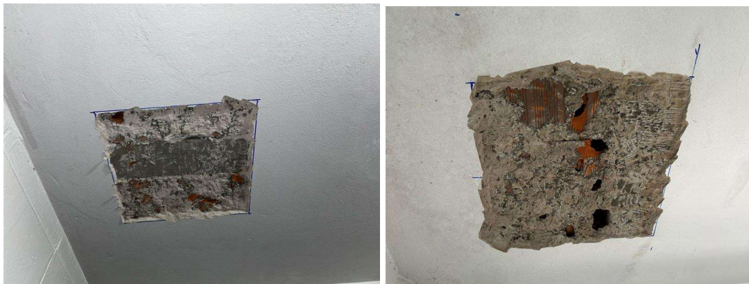
Figura 12 e 13 – aberturas na laje existente.
