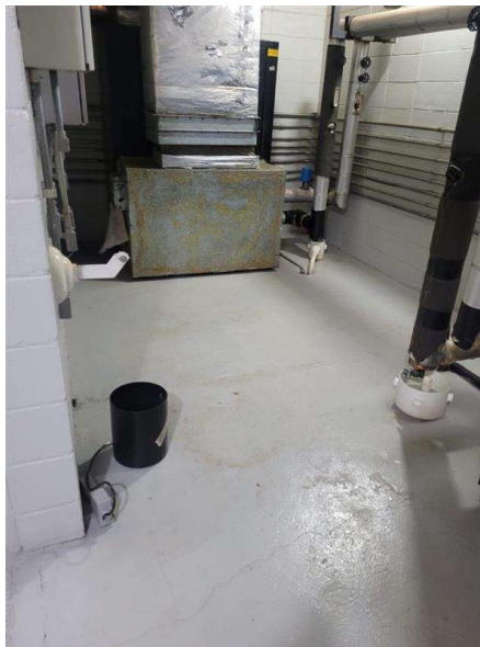
Figura 10 – Laje da casa de máquinas que deverá ser modificada.
