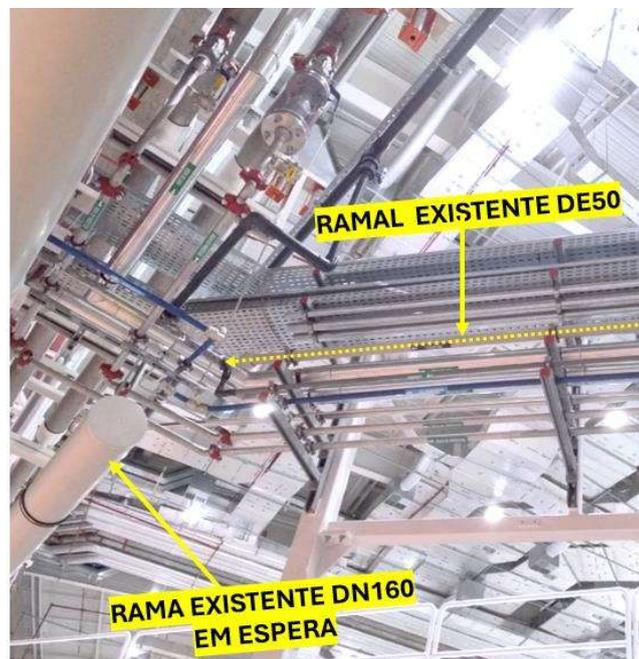
**Figura 3 - Região de conexão do ramal principal e ramal da linha**
