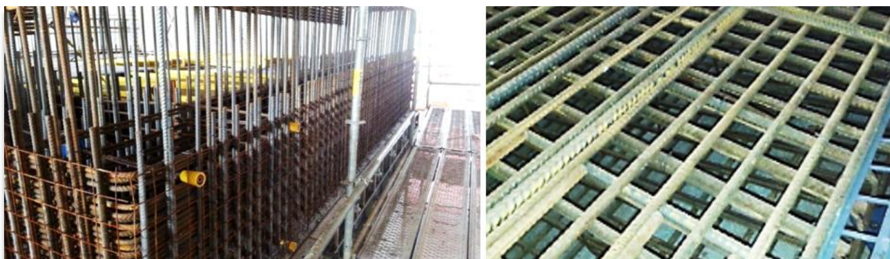
Figura 10 – Armação de paredes e piso
