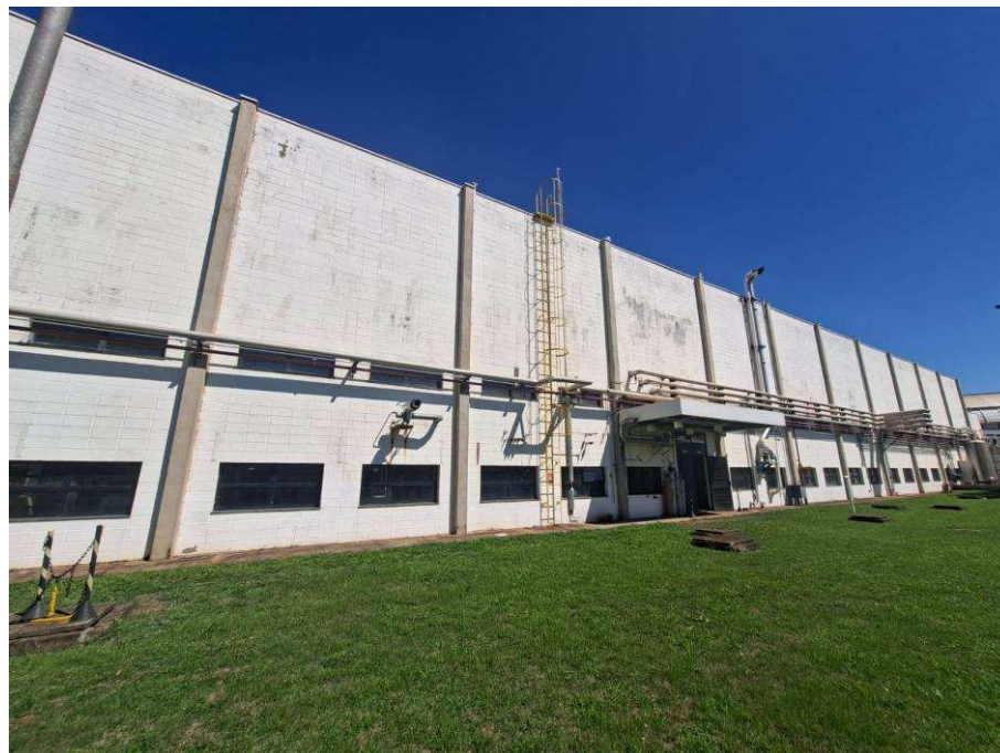
Foto 2: Fachada Planta Piloto
