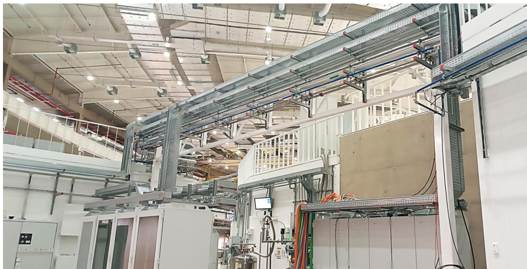
Figura 6: Foto Utilidades e Pipe Line
