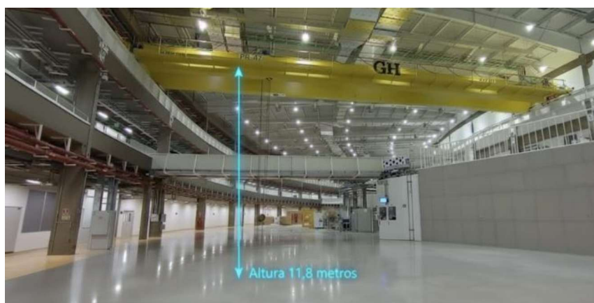
Figura 14: Ponte Rolante para transporte de materiais
