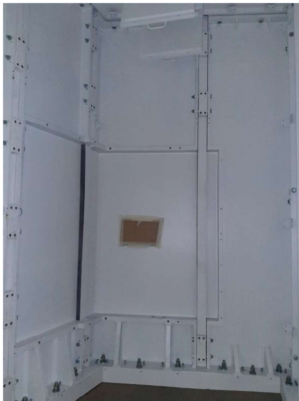
Figura 12 - Condição do local de instalação.
