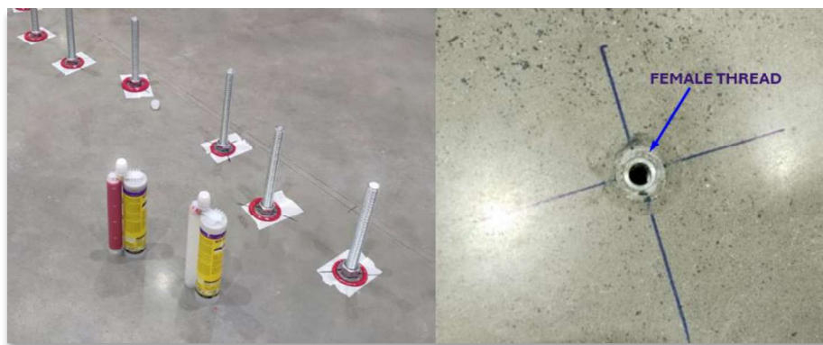
Figura 7: Chumbadores químicos (Hall Experimental)
