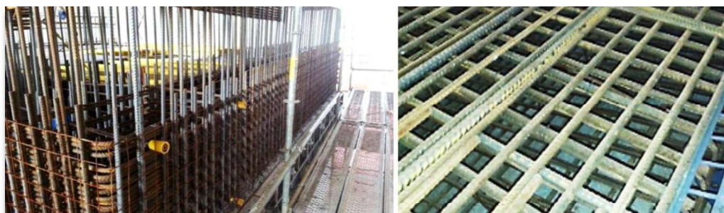
Figura 5 - Armação de paredes e piso
