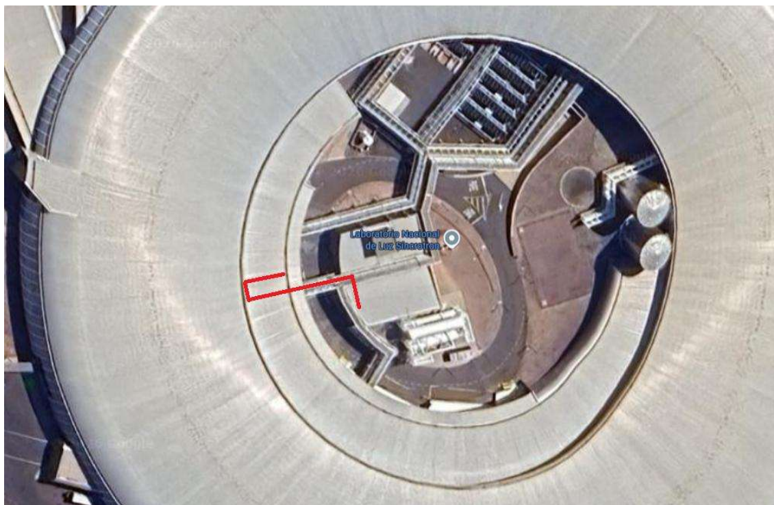
Figura 1 – Vista aérea do percurso entre a Sala de UPS's EATON e a Sala de Compressores de Hélio.
