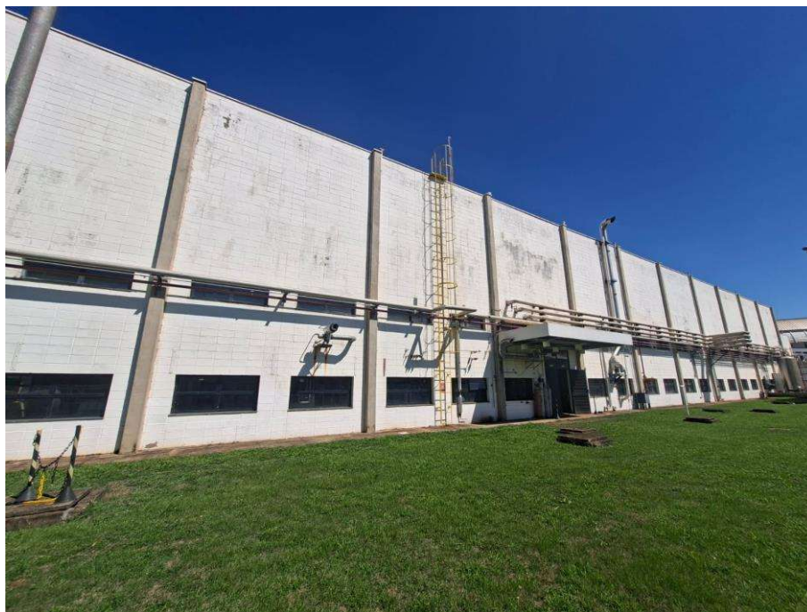
Foto 2: Fachada Planta Piloto
